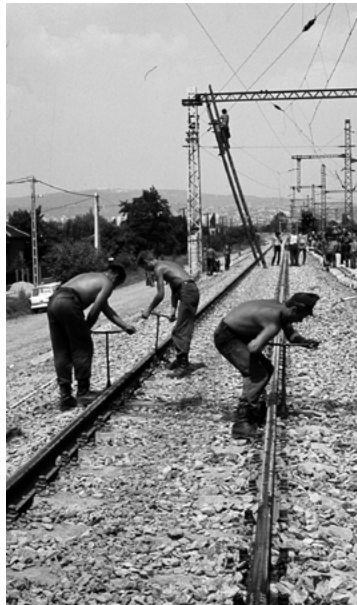
4. kép: Kelenföld pályaudvar rekonstrukciója. Honvédek a leszorító csavarokat húzzák meg Tyrefond kulccsal. MÁV Archívum X20247802.
