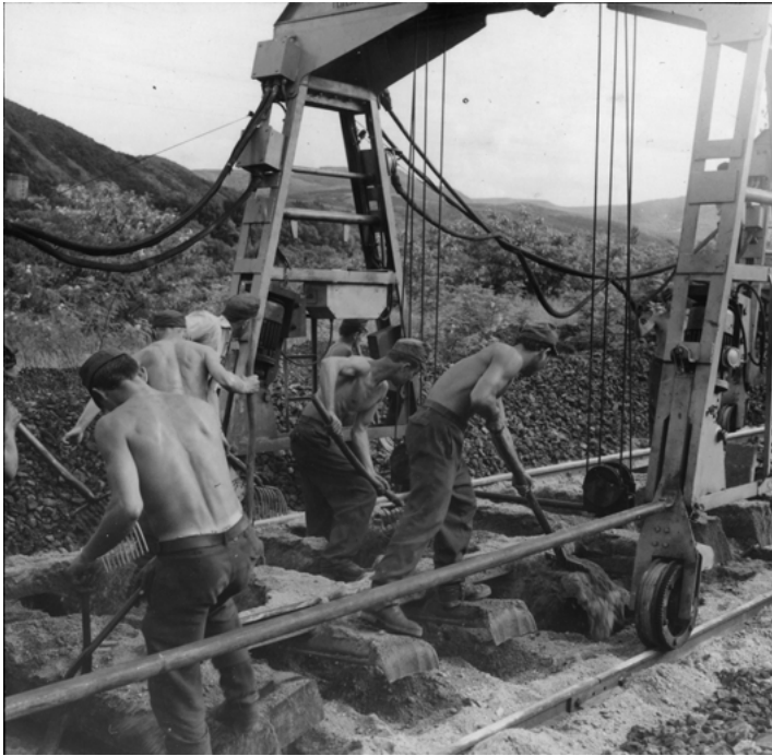
3.kép: Elhasználódott vágányzat bontása portáldaruval, 1971. Érdekesség a Magyarországon kevés helyen alkalmazott vasaljas sínmező. MÁV Archívum X20246478.
